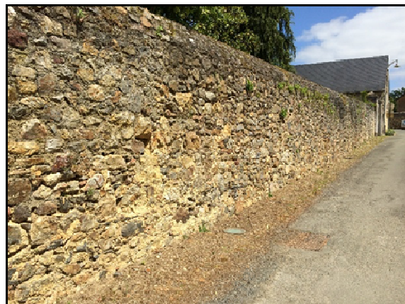
Murs de clôture moellons –
